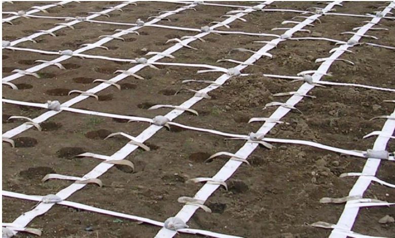
水平ドレーン材の布設状況
