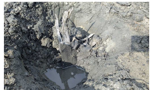
写真-1 掘り起こし前の鉛直ドレーン材
