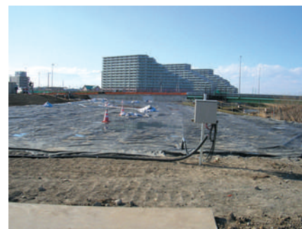
ポンプ運転状況 計測管理を行いながら、所定の目標値に達するまで運転します。
