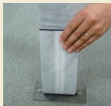
アンカープレート取付
