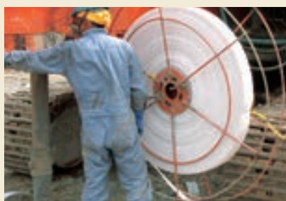
ドレーン材取付
