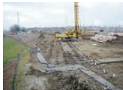
鉛直ドレーン打設 従来のプラスチックドレーンと同様の機械で打設します。
